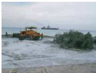
Vertimiento de arena en la playa de Varadero. 2009.
