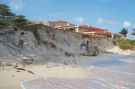
Tramo de la playa de Varadero severamente afectado. 2007.
